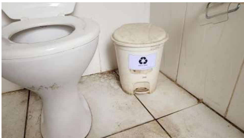
Figura 04 – Lixeira do Banheiro Feminino para Descarte de Resíduos Comuns.
