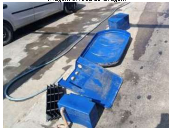
Imagem 5. Manutenção da caixa separadora.
